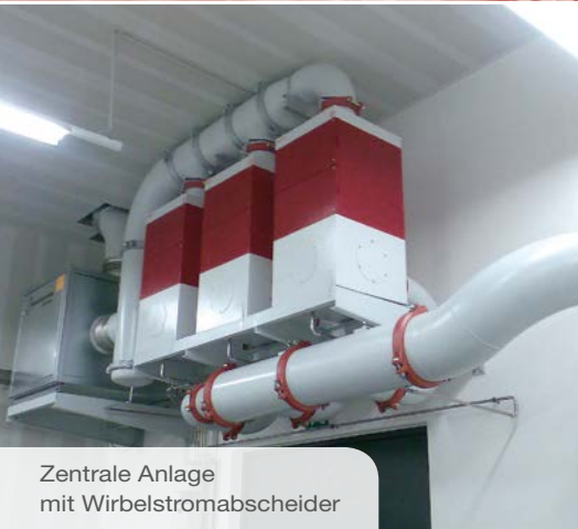
Öldichtes Rohrsystem
