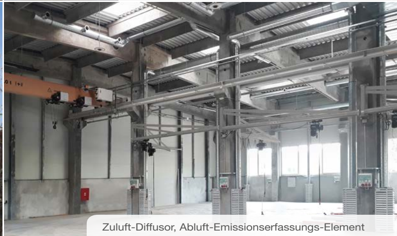
Schichtlüftung in Stahlbau-Schweißhalle
