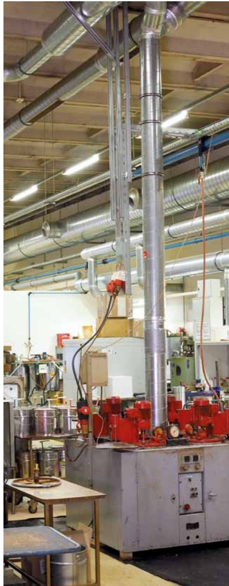
Teil der Lüftungsanlage an einem Arbeitsplatz in der Gießerei der asma Kunststofftechnik GmbH Bild: asma GmbH
