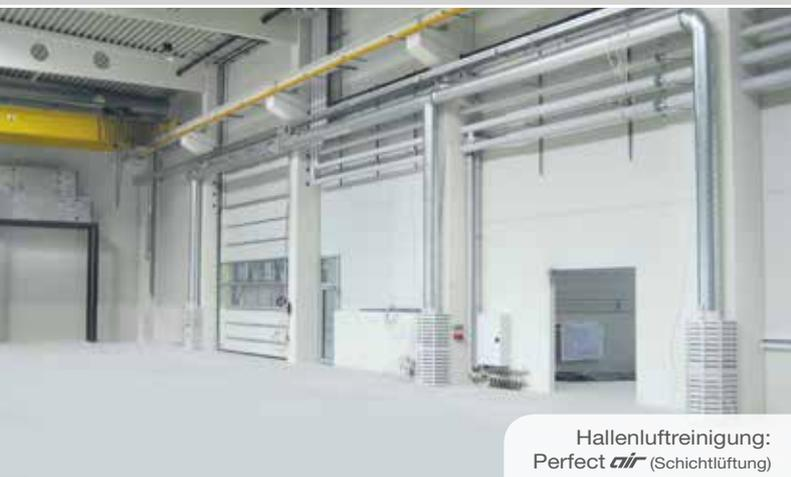
Hallenluftreinigung: Perfect *air* (Schichtlüftung)
