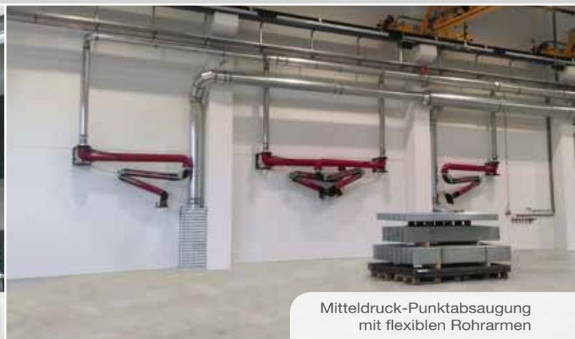
Mitteldruck-Punktabsaugung mit flexiblen Rohrarmen
